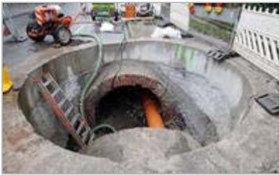
Baustelle Cleverstraße: Hier wird das Gewölbe des Krähenberger Bachs saniert. Das Wasser fließt derzeit über das Kunststoffrohr. Nach Ende der Arbeiten wird die große Montageöffnung wieder geschlossen. (WR-Bilder: Volker Speckenwirth)
